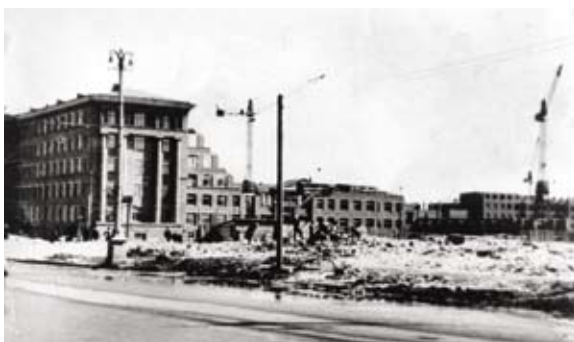
НЭТИ-НГТУ. Строительство 1 корпуса
